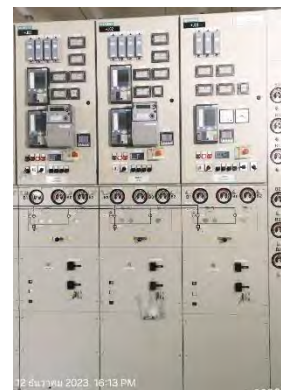
ภาพที่ 2.2-46 ระบบป้องกันทางไฟฟ้า (Relay) ที่เครื่องกำเนิดไฟฟ้า และหม้อแปลงไฟฟ้า
