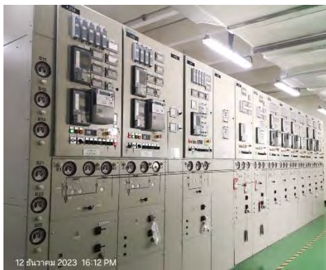
ภาพที่ 2.2-46 ระบบป้องกันทางไฟฟ้า (Relay) ที่เครื่องกำเนิดไฟฟ้า และหม้อแปลงไฟฟ้า
