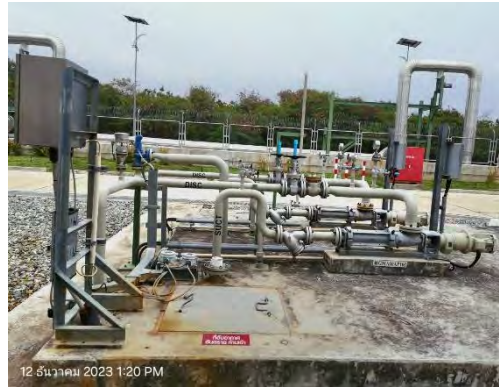
ภาพที่ 2.2-6 ระบบรวบรวมน้ำที่อาจปนเปื้อนน้ำมัน
