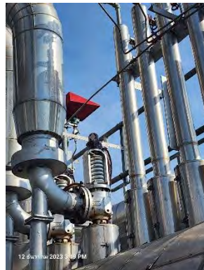
ภาพที่ 2.2-42 ลิ้นนิรภัย (Safety Valve) ที่ท่อ steam ของหม้อน้ำ
