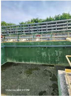
ภาพที่ 2.2-11 บ่อพักน้ำฉุกเฉินขนาด 320 ลูกบาศก์เมตร
