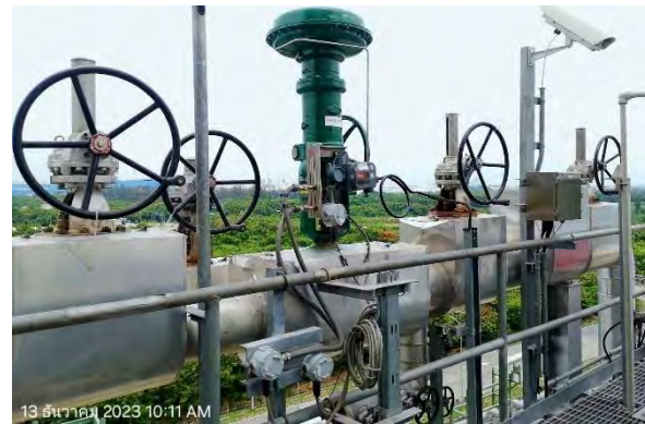
ภาพที่ 2.2-37 Shut-off Valve บริเวณ Connection
