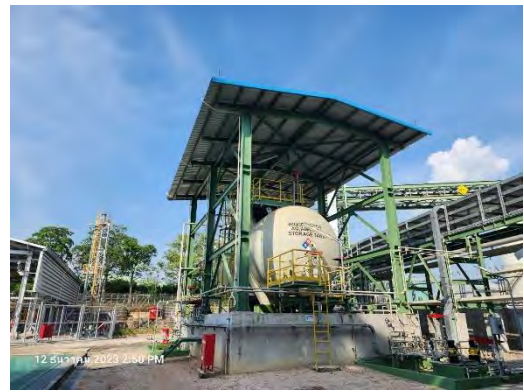
ภาพที่ 2.2-32 ถังกักเก็บแอมโมเนียไฮดรอกไซด์เหลว
