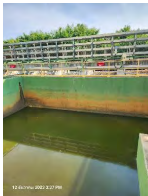
ภาพที่ 2.2-9 บ่อพักน้ำทิ้ง ขนาด 320 ลูกบาศก์เมตร
