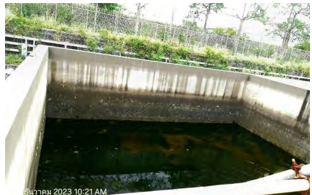
ภาพที่ 2.2-10 บ่อพักน้ำทิ้ง ขนาด 1,800 ลูกบาศก์เมตร
