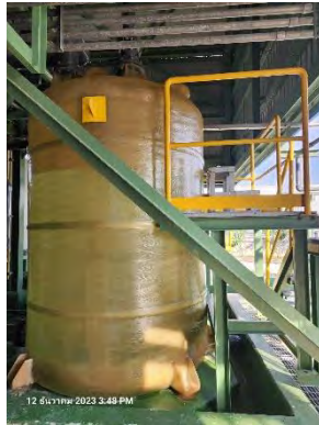
ภาพที่ 2.2-5 ถังปรับสภาพน้ำ (Neutralization Tank)
