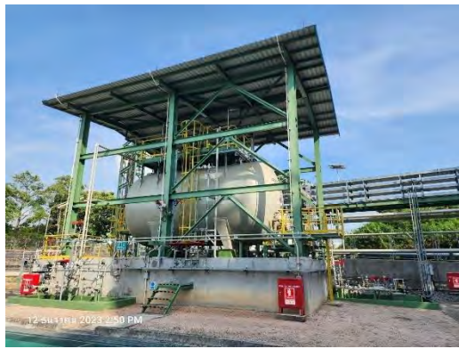
ภาพที่ 2.2-32 ถังกักเก็บแอมโมเนียไฮดรอกไซด์เหลว
